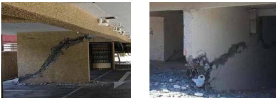
图1.1 地震中的剪力墙破坏 (图片来源于网络)
